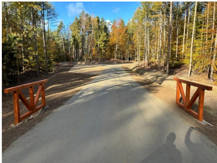
Przebudowa drogi w Leśnictwie Kamień.
